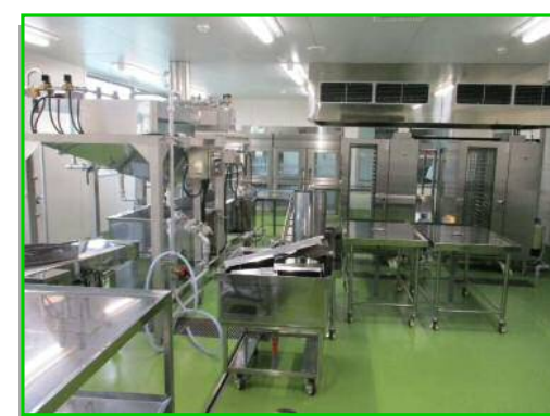
揚げ物・焼物・蒸物室
