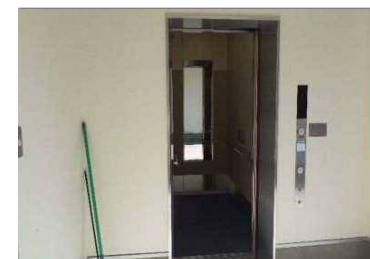
1階EV内装 奥行:2055、幅:1500
