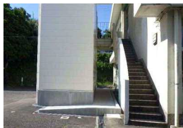
躯体右側部分 スロープが通常の出入口
