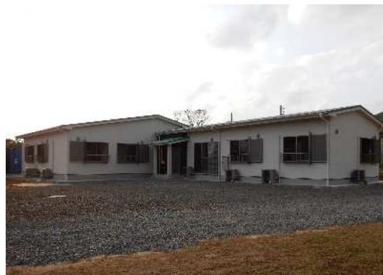
グラウンド側から見た寄宿舍 寮室(右手3室、左手3室)
