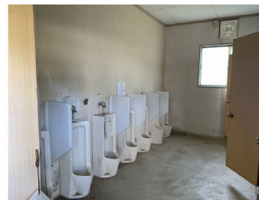
着工前写真 小便器
