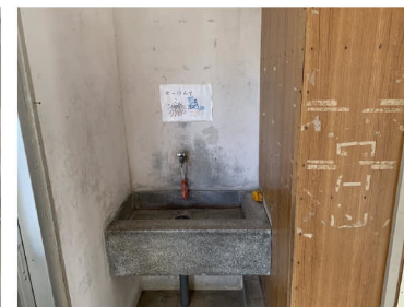
着工前写真 手洗い
