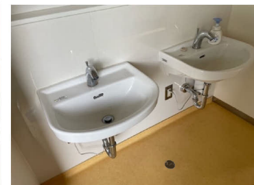
完成写真 (自動水栓化)
