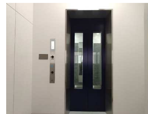
エレベーター（2階）
