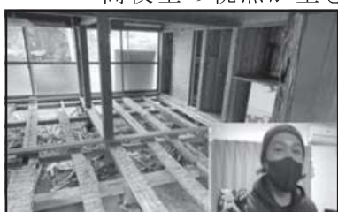
図7 改修予定として取り組んだ空き家及びテレビ会議
