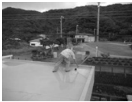
写真4 屋根の排水溝に挿しているところ
