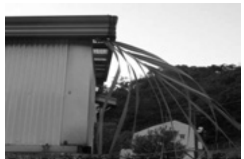
屋根の角にシバを挿した例
