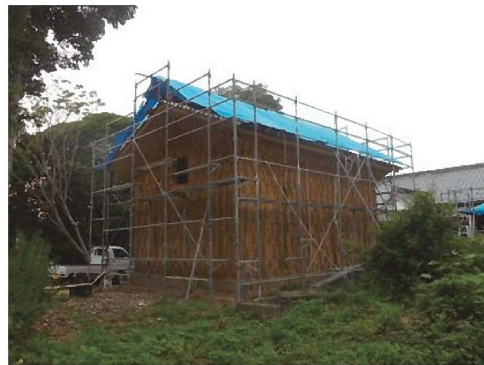
建造物の修復 （出水市阿多邸）
