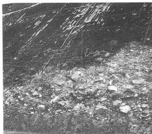
写真－８ 糸木名層の礫（ダム建設現場）
