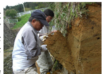
▲写真② 剥ぎ取り作業
