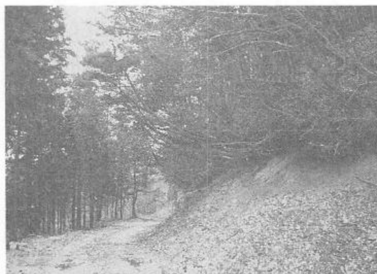
霜による法面崩落のため屈曲した樹木
