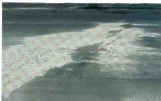
写真-14 アスファルト面での噴砂
