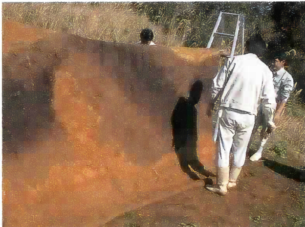
写真11 水道水による洗浄
