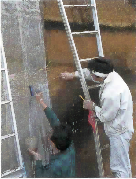
写真9 竹串による圧着
