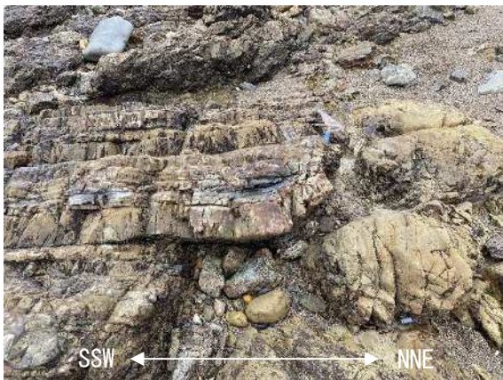
図 8 断層による地層の引きずり(ブロック C①)
