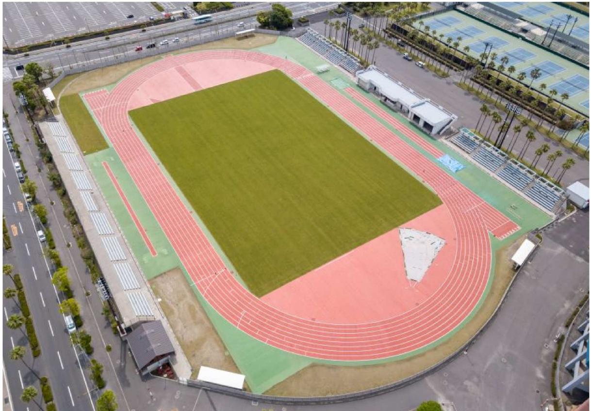
写真番号 8 (鹿児島県立鴨池補助競技場)
