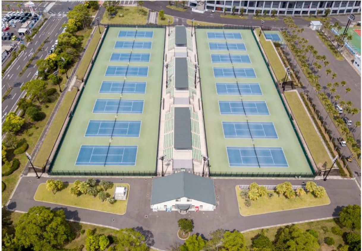
写真番号 7 (鹿児島県立鴨池庭球場)
