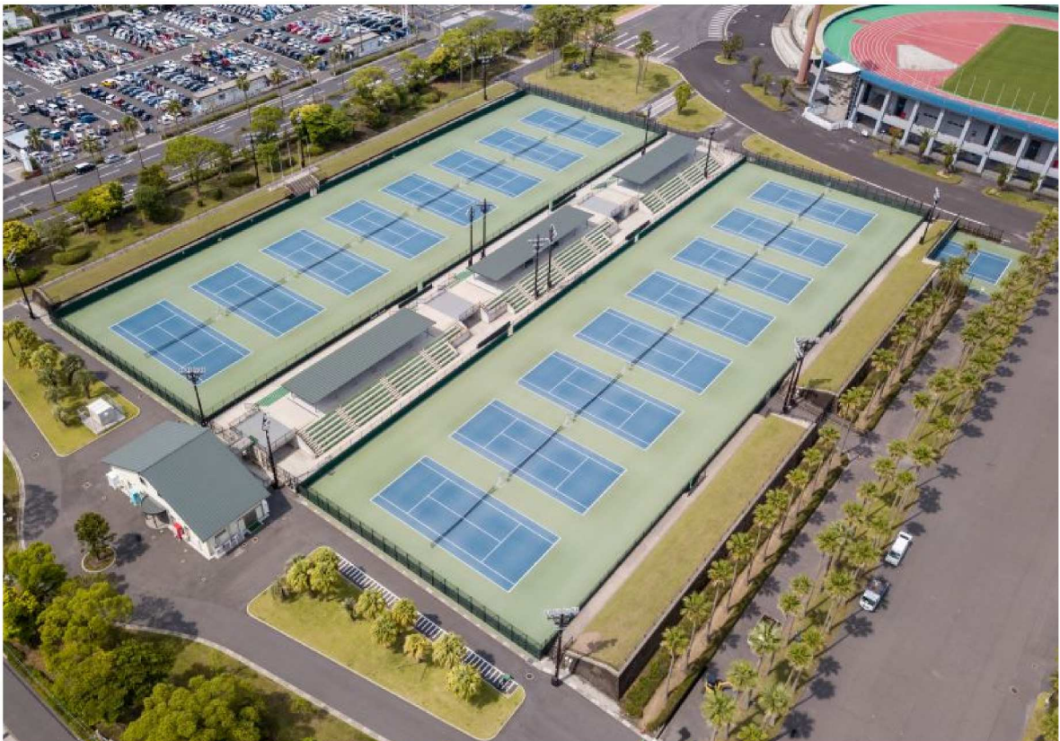
写真番号 6 (鹿児島県立鴨池庭球場)
