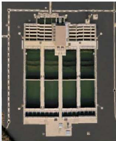
●フロック形成池・沈殿池 (真上から)
