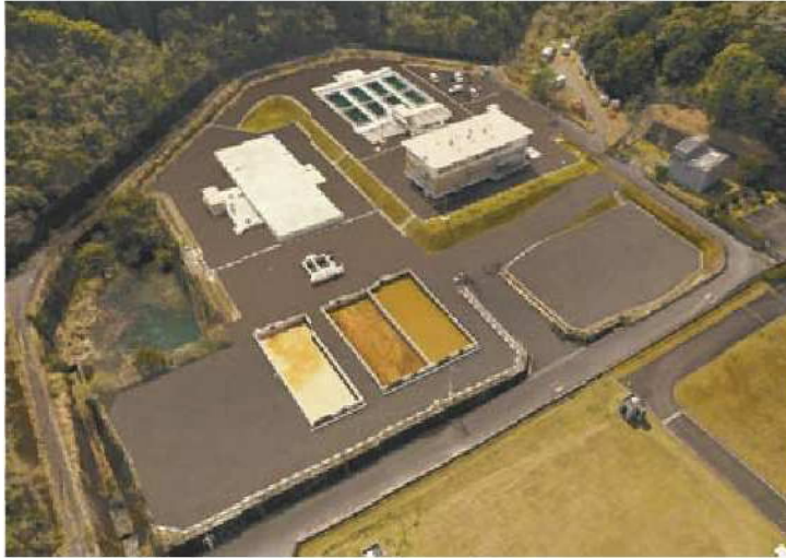
●浄水・配水施設 全景
