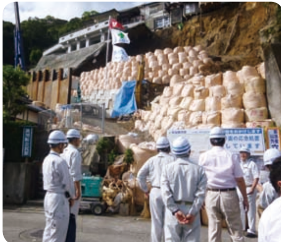
法面崩壊現場を視察(10月)
