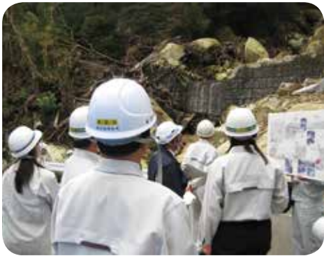
県道屋久島公園安房線の災害復旧現場＝屋久島町・11月
