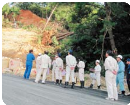
大規模崩落現場を調査（奄美市知名瀬）
