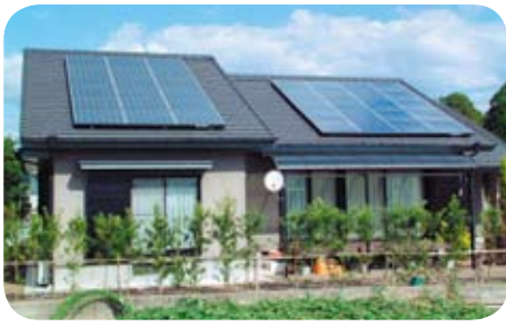
太陽光発電システム
