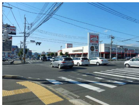
事業実施中の箇所 鹿児島市東郡元
