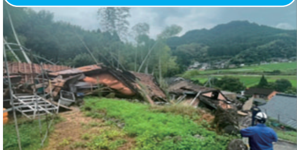
がけ崩れによる住家被害の状況(始良市)
