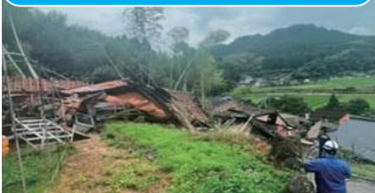
がけ崩れによる住家被害の状況(始良市)
