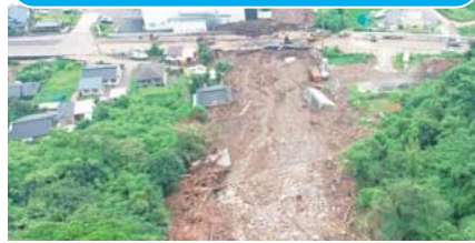
がけ崩れによる道路被害の状況(霧島市)
