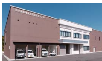
環境放射線監視センター
