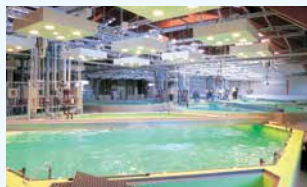
▲施設内部の様子
