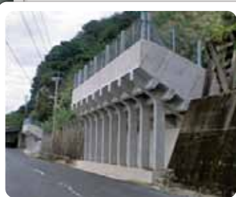
復旧後（ロックキーパー）
