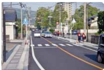
薩摩川内市平佐 段差解消などの歩道整備
