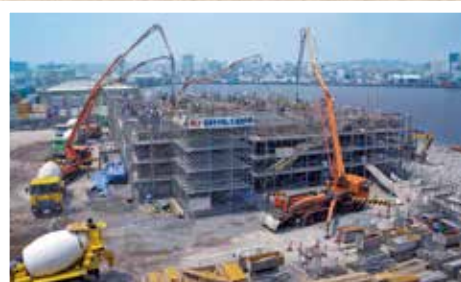
旅客待合所 ポンプ車でコンクリートを流し込んでいます。
