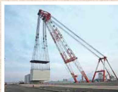
耐震強化岸壁 (水深9m) 岸壁になるコンクリート製のケーソン※ を運んでいます。
