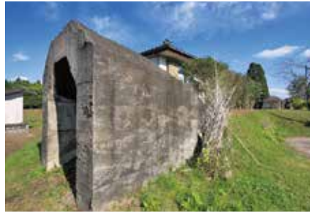
通信司令部壕跡 現在壕の地上には公民館が建っていて、中に入ることはできません。
