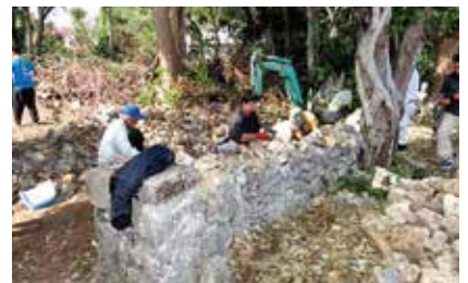
石垣修復作業の様子
