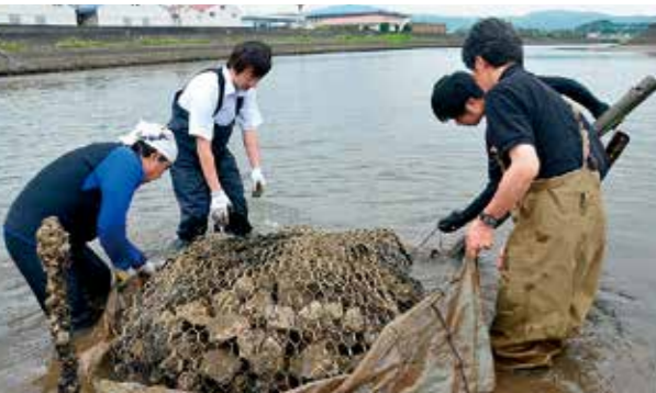
石倉かごを設置しウナギの住処造り
