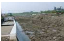
災害復旧の進む高尾野川 出水市高尾野町西水流地内
