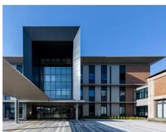
図表 5-8 庇・ルーパー等により空調負荷を 低減した庁舎（高島市役所）
