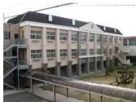
耐震診断を実施した教育施設
