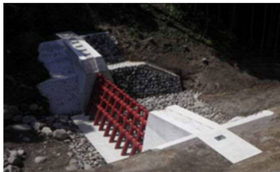
川添川(湧水町)砂防堰堤
