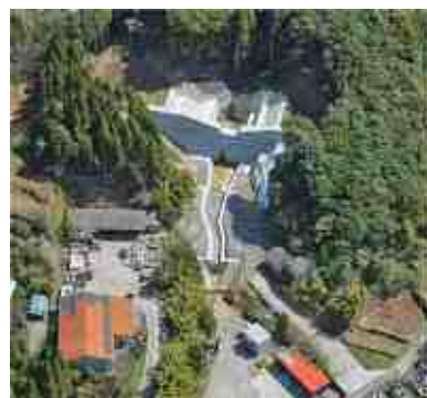
栗山追川(いちき串木野市)砂防堰堤
