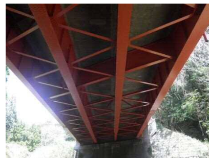
橋梁補修(塗装塗替)
