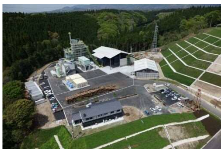
木質バイオマス発電施設
