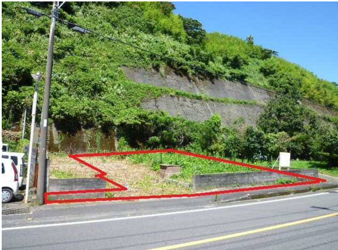
③ 南東側から撮影
