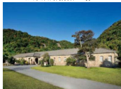
旧集成館機械工場
