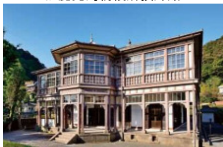
旧鹿児島紡績所技師館
