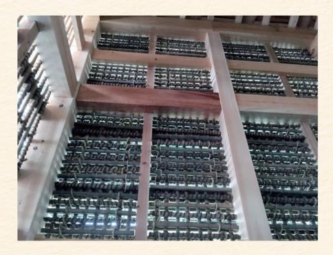
壁の外側は、土を何重にも塗り重ねていくので、壁厚が厚くなります。 土を塗り重ねていく時に、土が下がって剥げ落ちない様、土をしっかりと付けていくために、 下げ縄を取り付けます。
