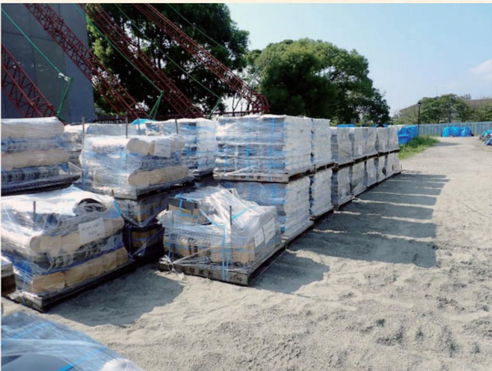
御楼門の瓦工事は、屋根の重さを少しでも軽くするために、空葺き工法(葺土を使わない)で施工します。
