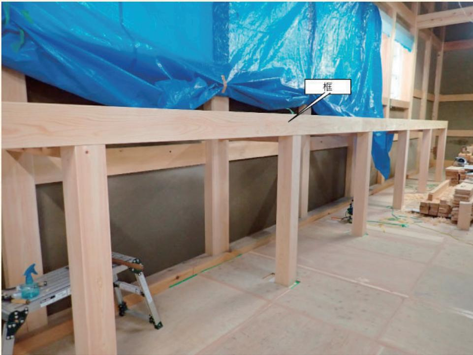
石打ち棚には、床板を張るために根太(ねだ)を取り付けます。
