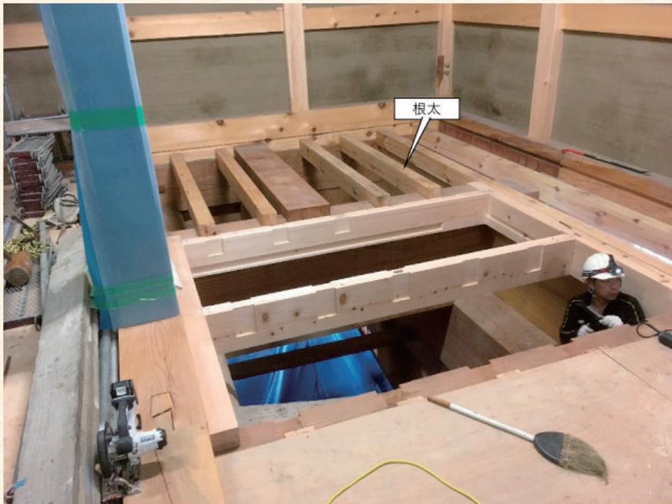
根太の天端を調整し終わると、床板(巾24cm・厚み45mm)を張ります。
