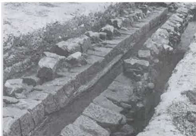
写真 2-21 石組排水溝 (市教委1998)
