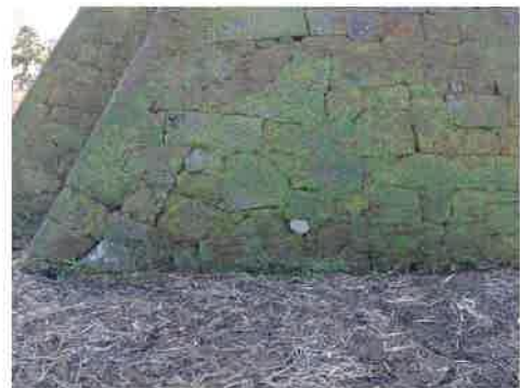
写真 2-31 H002面東隅の石垣
