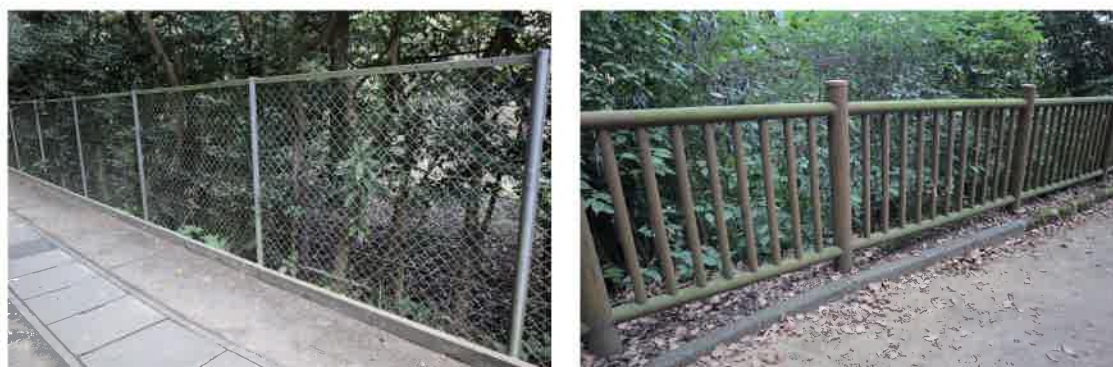
図4-5 整備の現状（左：境界フェンス、右：転落防止柵）
