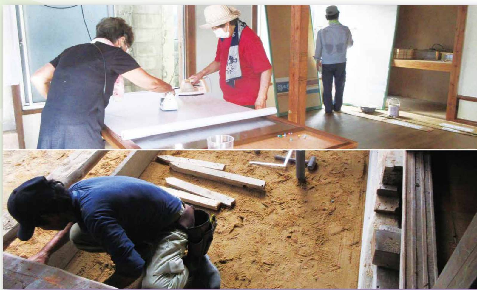
廃墟化した住宅リフォーム工事 専門的な作業以外は集落の住民で取り組みました。
