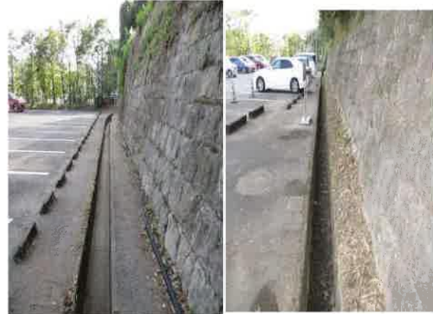
屋外駐車場側溝土砂さらい（作業後）
