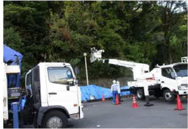
高所作業車を使つての作業②
