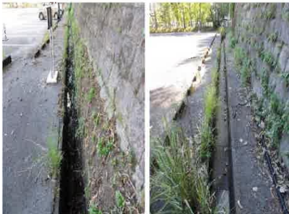
屋外駐車場側溝土砂さらい（作業前）
