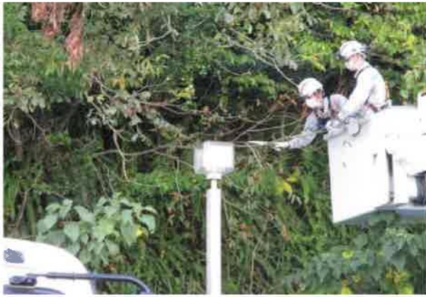
高所作業車を使つての作業①
