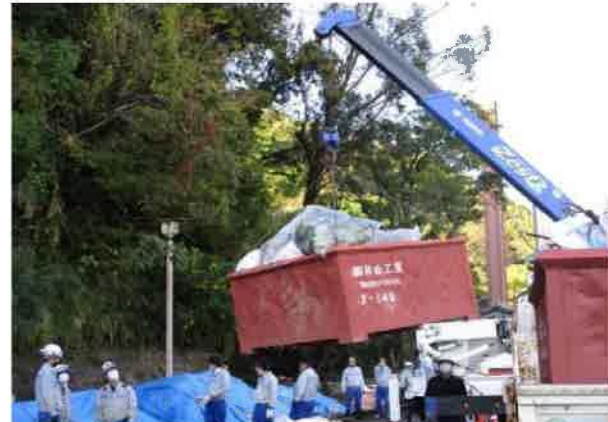
積み出し作業②
