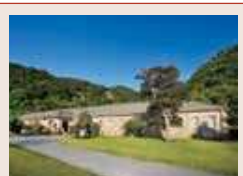
■ 旧集成館機械工場
