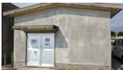
①電源局舎
