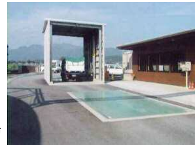
写真 消毒設備・トラックスケール
