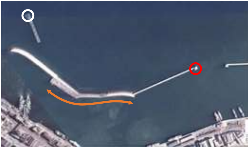
写真 6-9 1974(昭和 49)年 ～1978(昭和 53)年 頃の鹿兒島港
