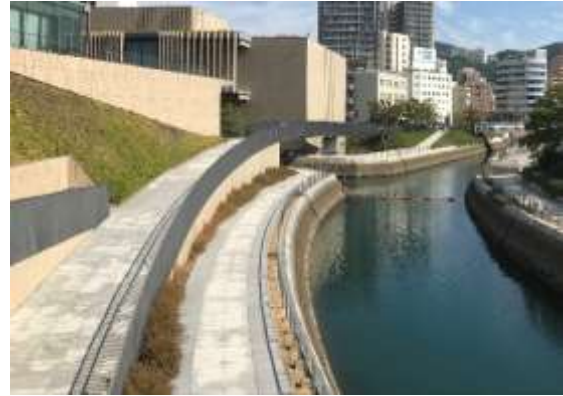
写真 6-33 スロープの設置
