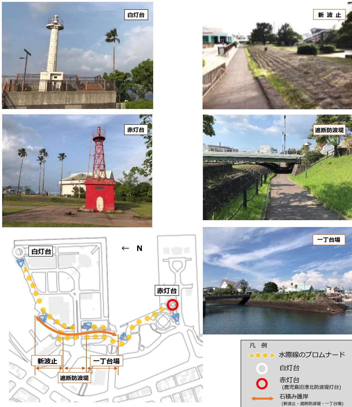
図 6-3 白灯台・赤灯台・石積み護岸の位置（国土地理院地図をベースに加工）
