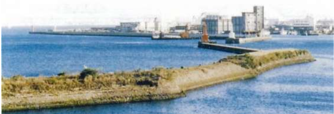
写真 2-4 1982(昭和 57)年頃の防波堤(新波止, 遮断防波堤, 一丁台場) と赤灯台(鹿児島旧港北防波堤灯台)
