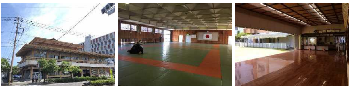
現武道館（1972 年 7 月竣工）
