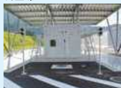
搬入受付、計量、目視検査、抜取検査を行います。
