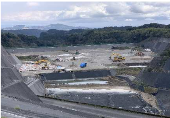
【最終処分場（清掃センター）】
